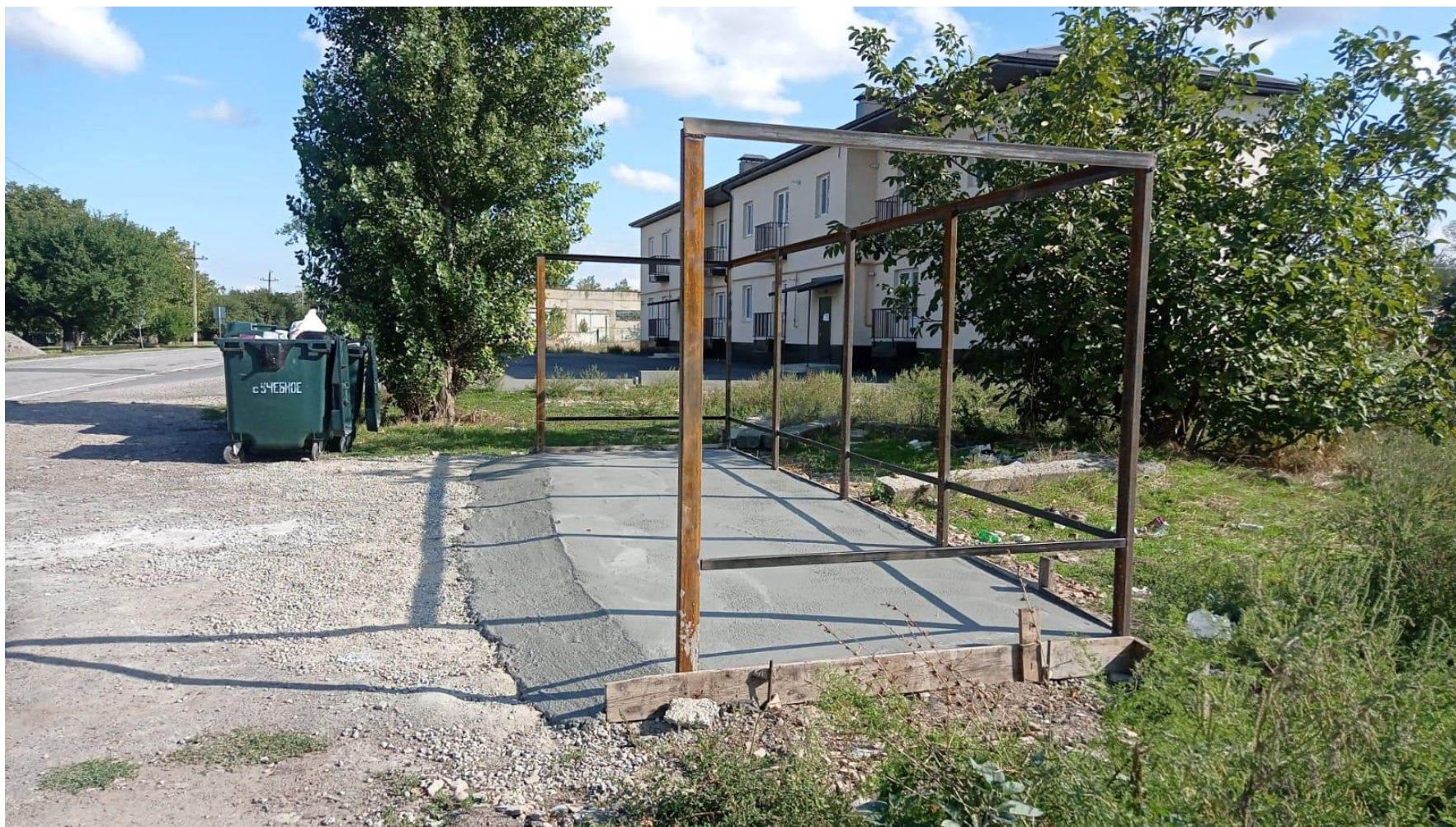
- установка обрешетки из стальных труб,
