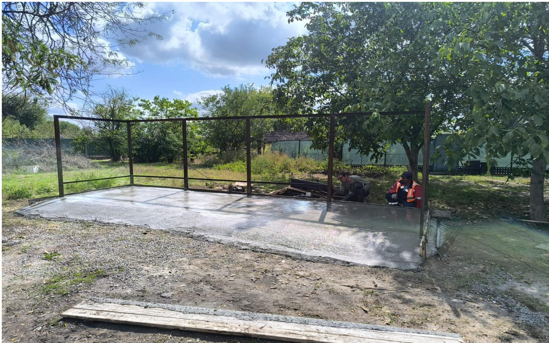
- огрунтовка металлических поверхностей грунтовкой
