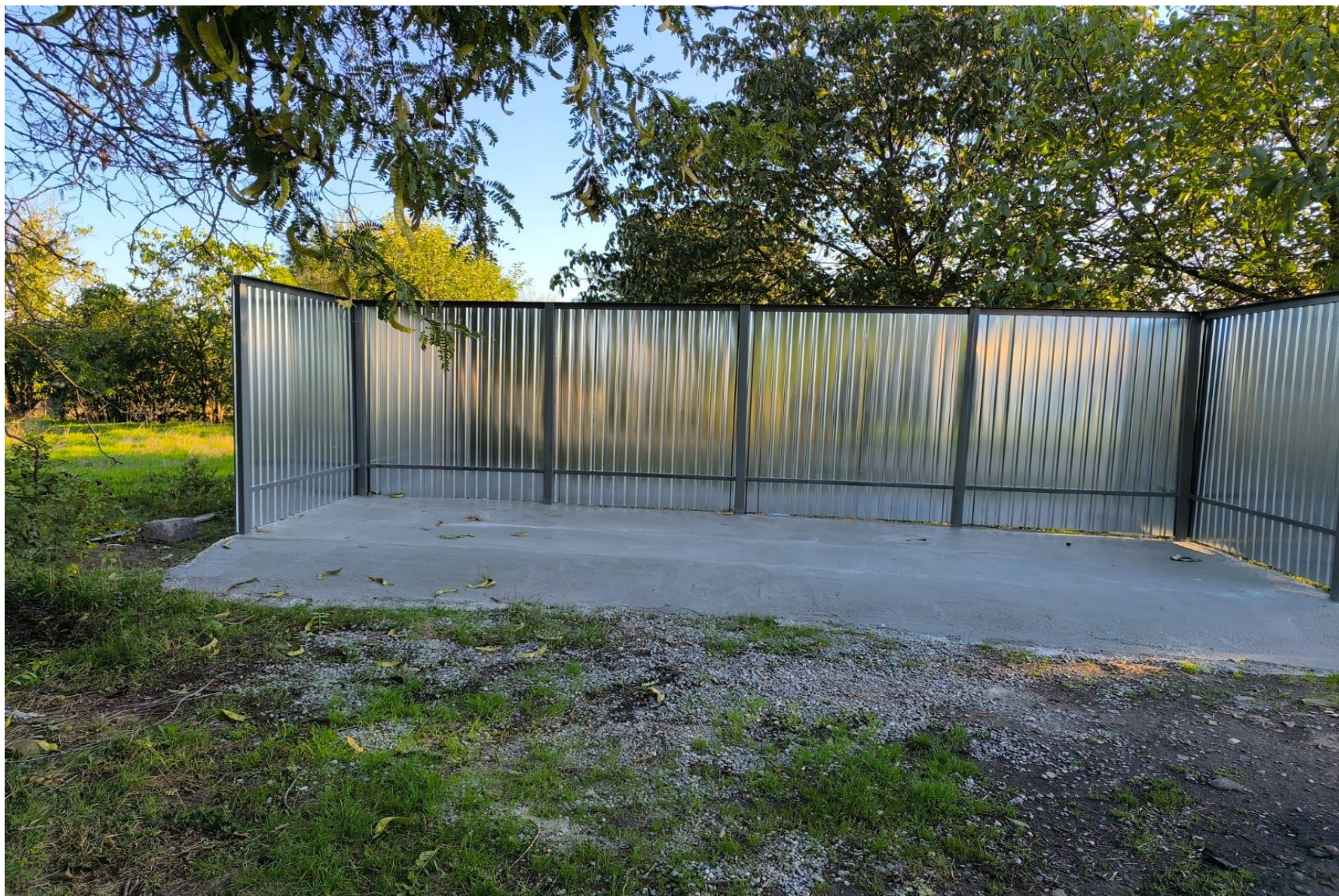
Работы по обустройству площадок для сбора ТКО завершены.
