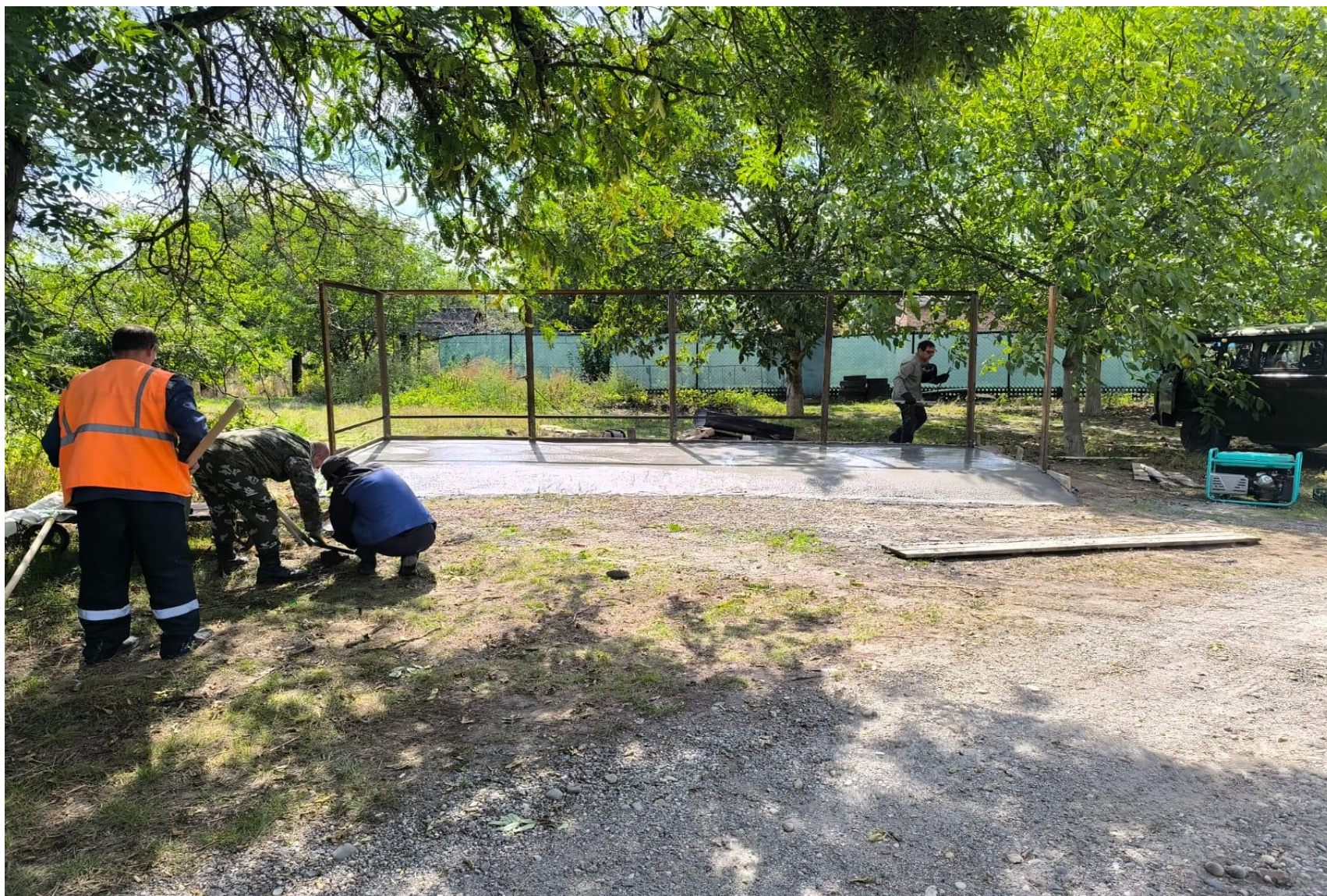
- устройство бетонной подготовки,
